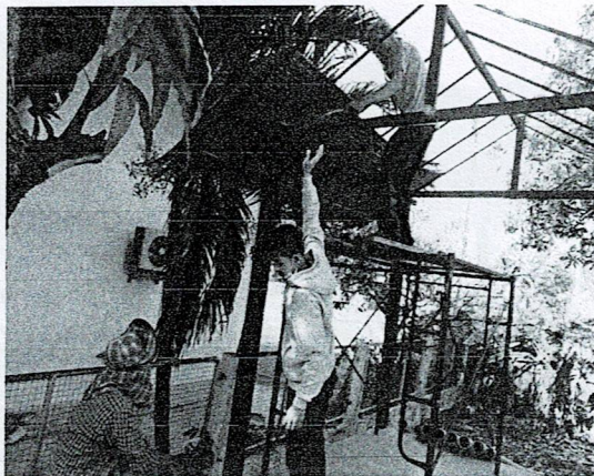
ดำเนินการขึ้นโครงเหล็กและมมหลังคาของที่อ่านหนังสือบนเรือ
