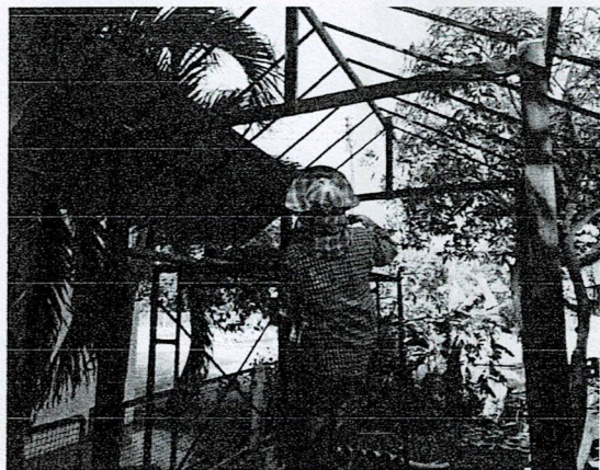
ดำเนินการขึ้นโครงเหล็กและมมหลังคาของที่อ่านหนังสือบนเรือ
