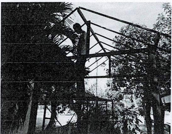
ดำเนินการขึ้นโครงเหล็กและมมหลังคาของที่อ่านหนังสือบนเรือ
